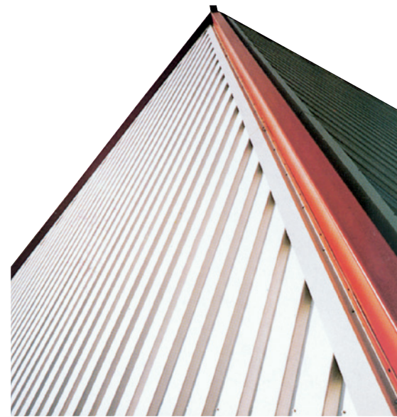
Abb. 4: Fassade aus Galvalume mit organischer Beschichtung
