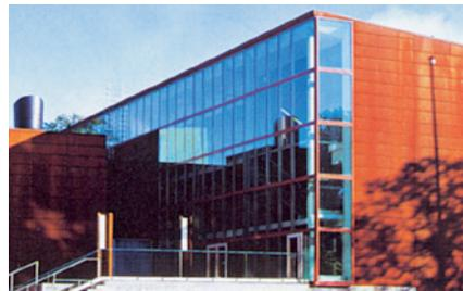
Fig. 2: façade de construction colorée d'une feuille d'acier galvanisé
